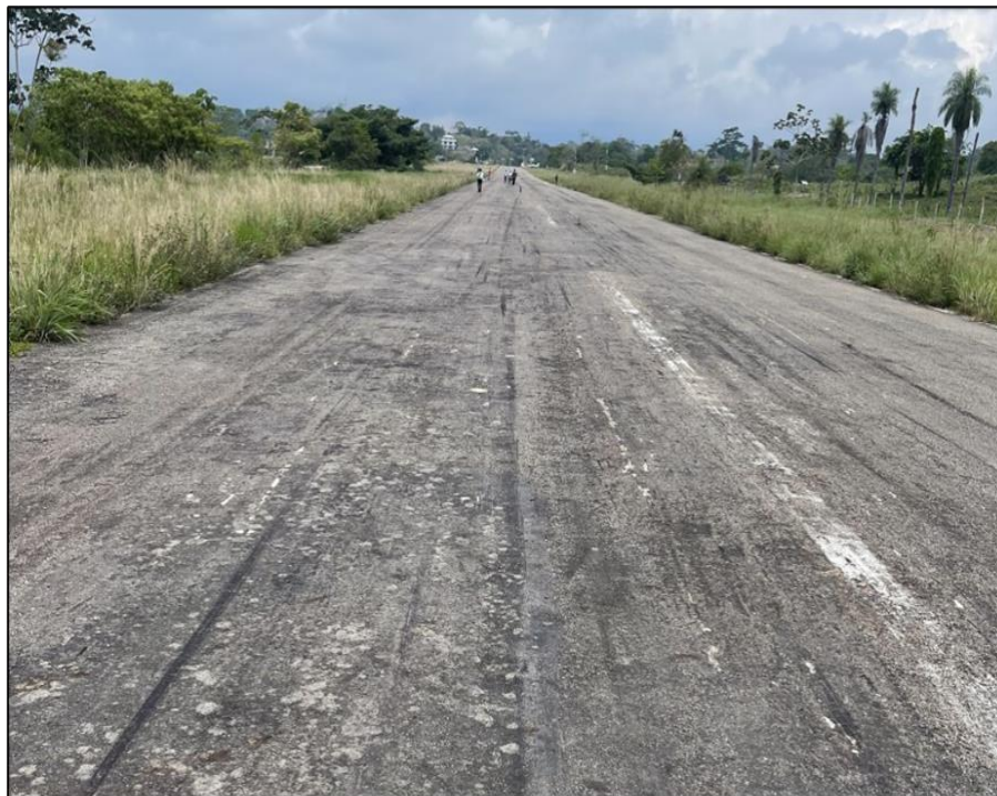
Fotografía No. 02 - Fotografía de la pista de Santa Rosa de Sur-Bolívar
